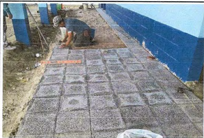
Foto 3: Mejoramiento de piso granito modulo 2
