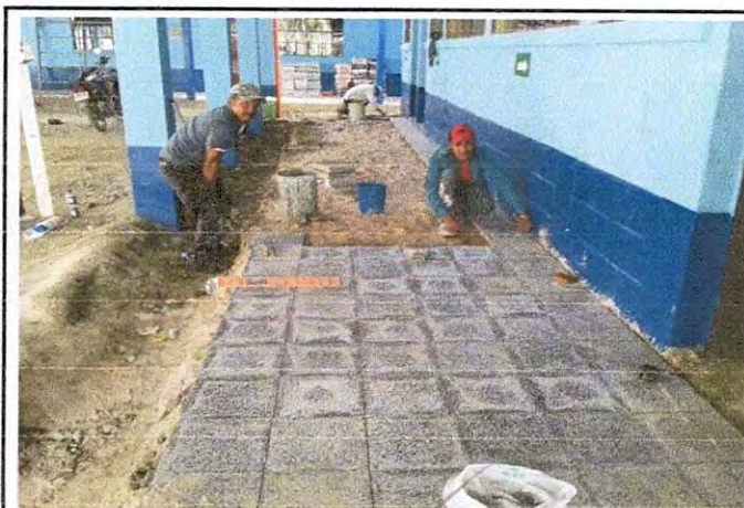
Foto 4: Mejoramiento de piso granito modulo 2
