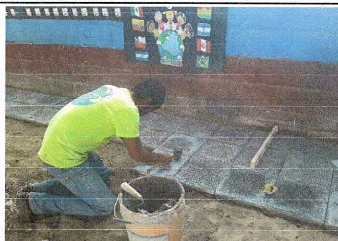
Foto 2: Mejoramiento de piso granito modulo 2
