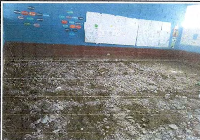
Foto 1: Mejoramiento de piso granito modulo 2
